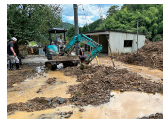
台風7号災害では、大雨による土砂崩れや浸水など大きな被害が発生しました
