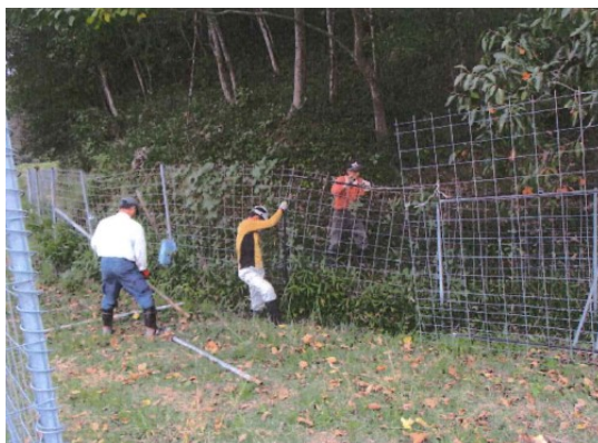
獣害柵の補修
