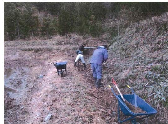
水路の泥上げ
