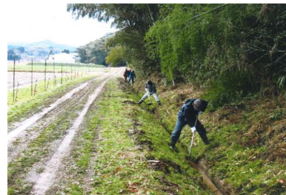
水路の泥上げ
