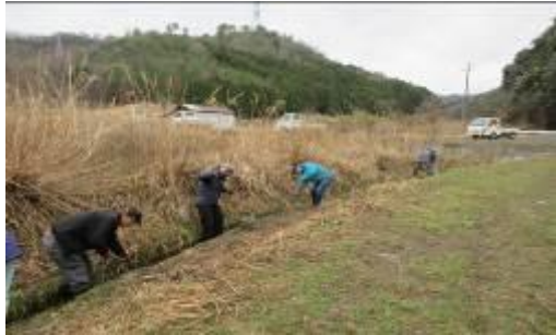
水路の泥上げ
