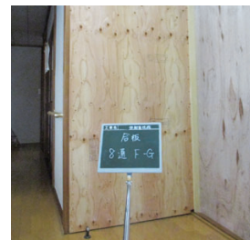
壁に合板を張り、住宅を補強
