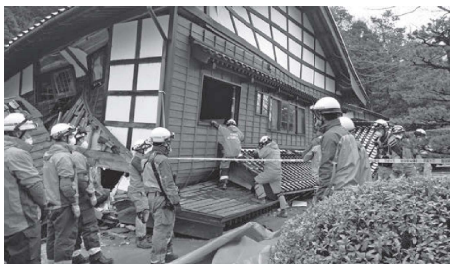
能登半島地震で被災した石川県珠洲市で救出活動に当たる市職員
