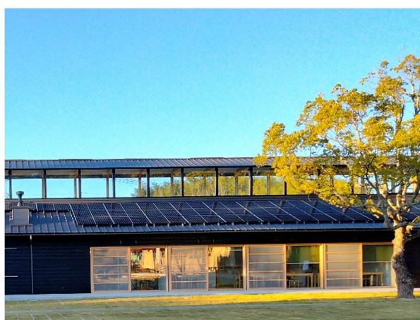
太陽光発電設備（里山交流研修センター）
