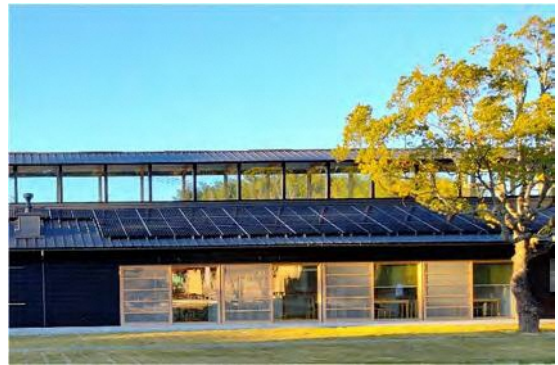
里山交流研修センターの屋根にある太陽光発電
