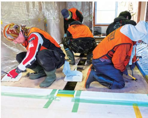
養生した室内で、床板の釘抜きを行う講習会参加者
