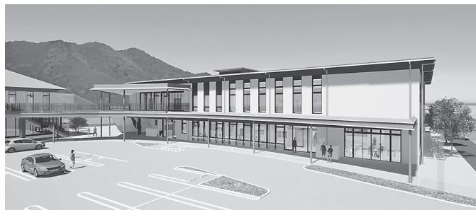
JR綾部駅北側に建設中の複合施設。11月23日に竣工予定
