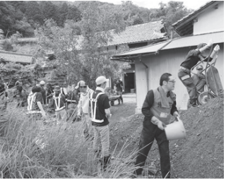
敷地に流れ込んだ土砂をバケツリレーや一輪車で撤去するボランティアと消防団員
