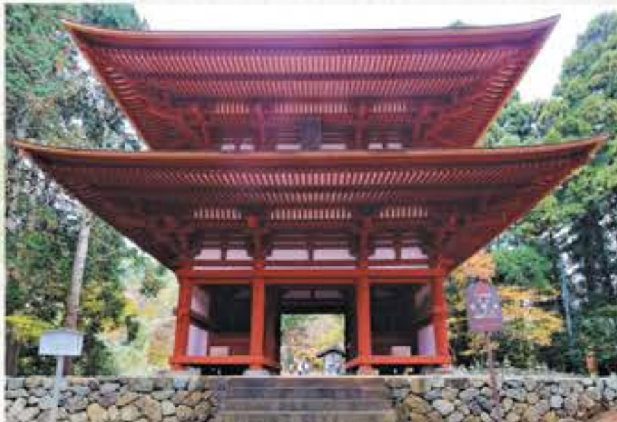
一階と二階両方に屋根を持つ「二重門」は、門の中でも最も格式の高い建築様式。歴史考証の観点からも大変貴重で、現在、京都府北部唯一の国宝建造物に指定されています。
