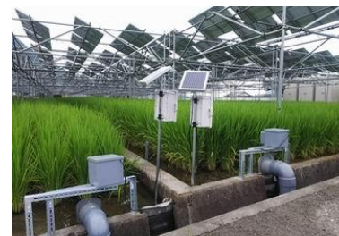
写真 営農型太陽光発電設備
