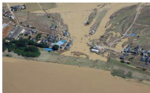
堤防決壊による家屋の流失(鬼怒川)
