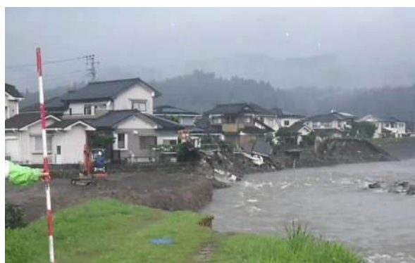
河岸侵食による家屋の倒壊(花月川)
