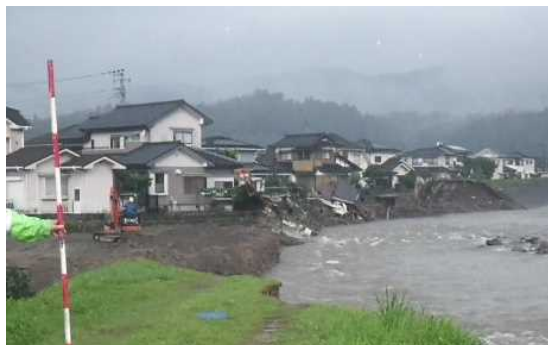
河岸侵食による家屋の倒壊(花月川)
