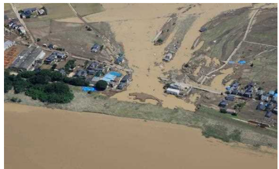
堤防決壊による家屋の流失(鬼怒川)
