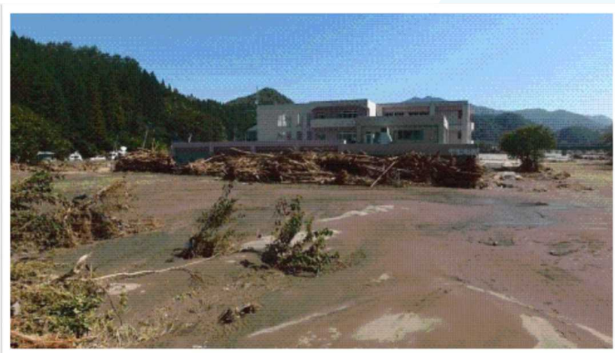
平成28年台風第10号による被害状況
