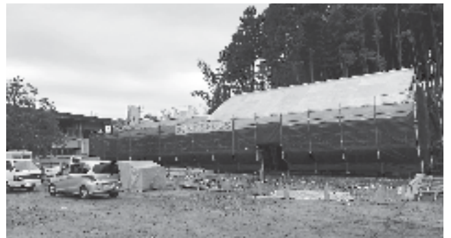
建設中の森もりホール
