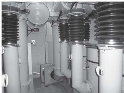
放射線防護対策設備(奥上林公民館)
