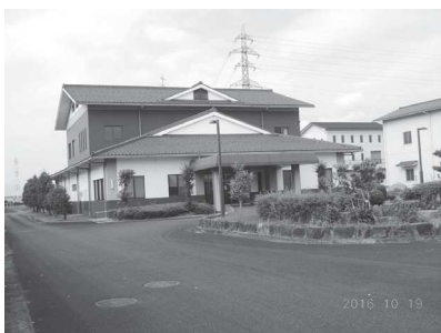
綾部浄化センター
