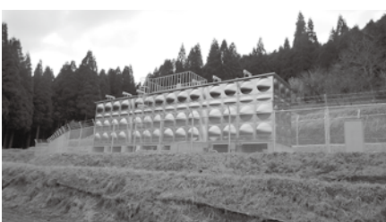
山家西簡易水道統合整備事業・貯水池
