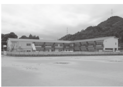
建設工事が進む東綾中学校
