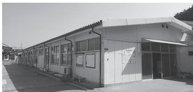
旧中筋幼稚園舎
