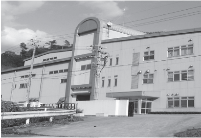
■綾部市クリーンセンター
