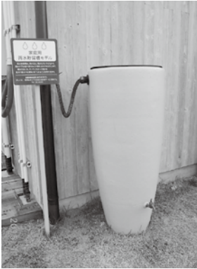
■家庭用雨水貯留槽
