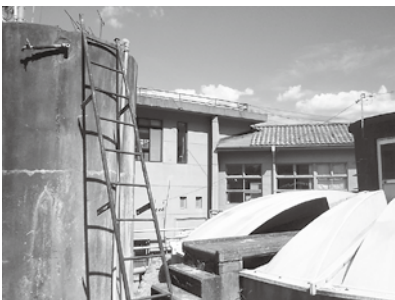
現在の第一浄水場
