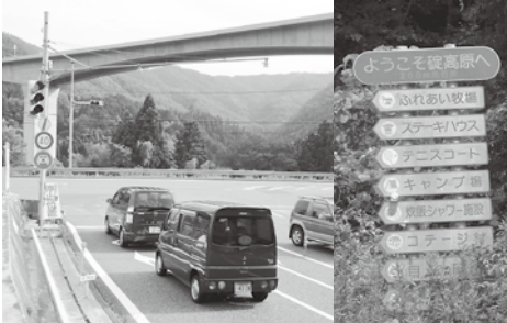
インター出口と案内看板の例
