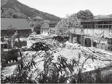
解体中の里山ねっとの旧体育館
