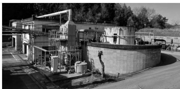
汚泥受入槽・汚泥貯留槽等の改修箇所
