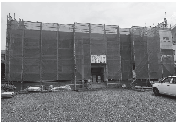
建設中の借上型市営住宅（駅前通）
