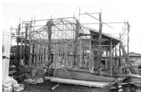
建設中の西八田放課後学級
