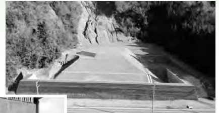
市道高津旭線道路災害復旧工事
