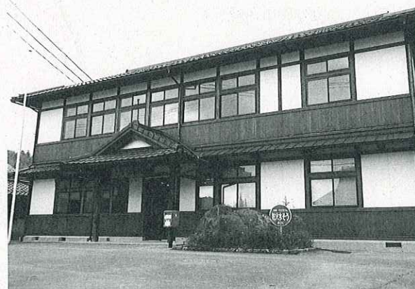
改修された志賀郷公民館
