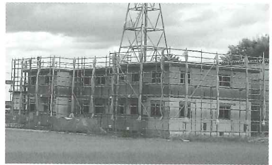
新築の借上型市営住宅（味方町）
