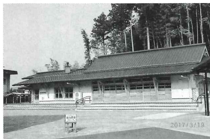
完成した森もりホール
