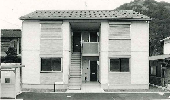
すでに入居されている借上型市営住宅(大島町)
