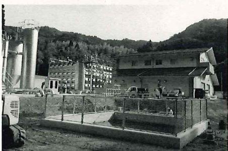
完成間近の第一浄水場
