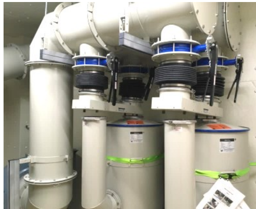
外気を取り込む巨大な空気清浄機(松寿苑)
