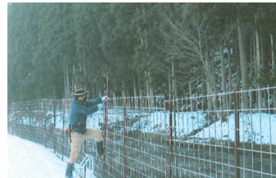
獣害柵の設置
