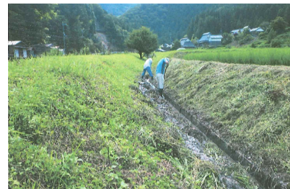
水路の泥上げ
