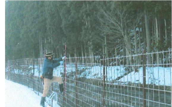
獣害柵の設置
