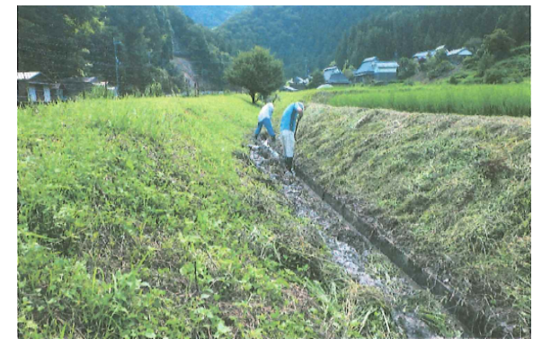
水路の泥上げ
