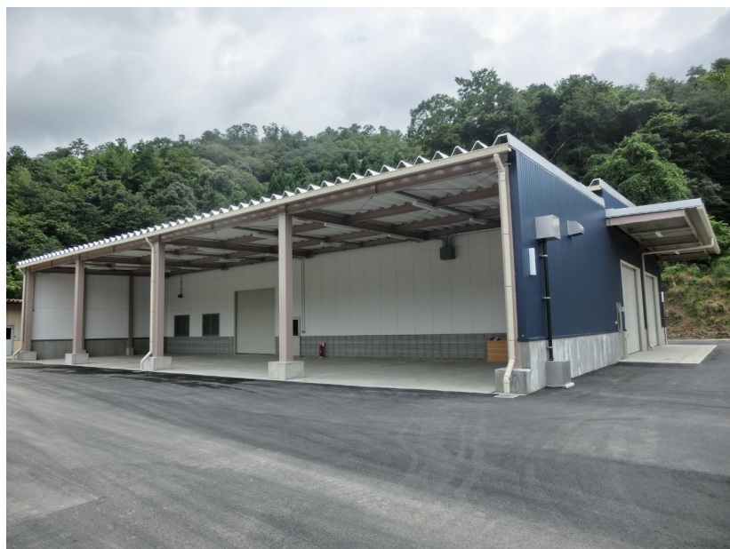
綾部市リサイクルセンター
