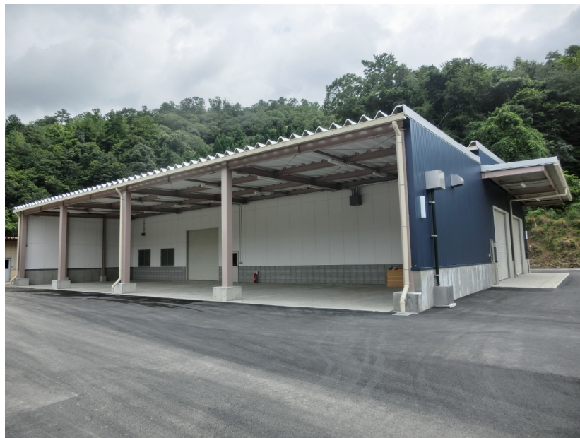
綾部市リサイクルセンター
