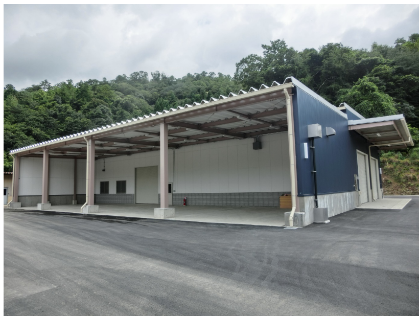
綾部市リサイクルセンター
