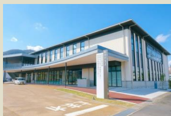
図書館・地域交流センター・ 子育て交流センター（あやテラス）
