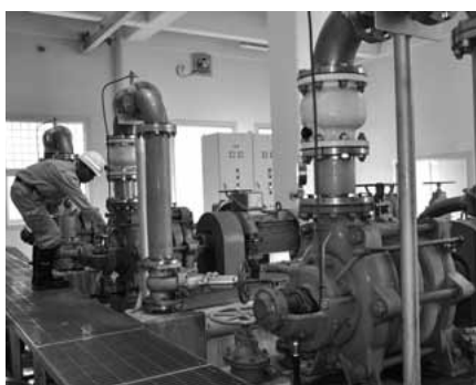
浄水場での点検作業
