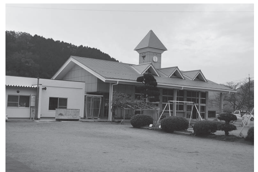
同園シンボルの時計の屋根などが再塗装され色鮮やかに
