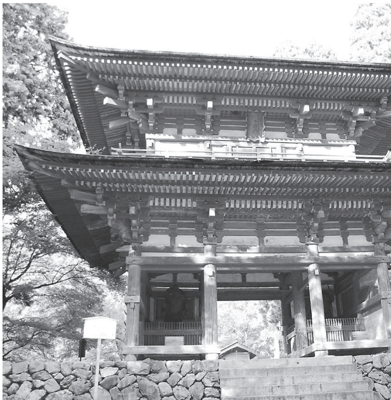
▶屋根の全面葺き替えて当時の重厚な屋根が蘇る。再塗装された、建立当時の美しいベンガラ塗りの色彩は現場で確認を(写真は修復前)
