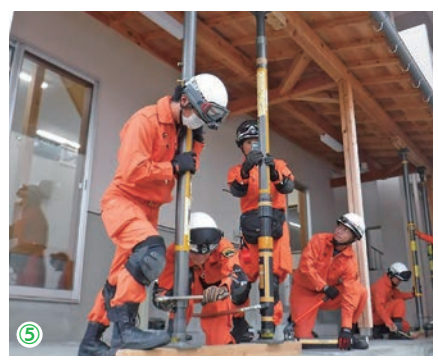
⑤ 救助活動中に家屋が倒壊しないよう支えます
