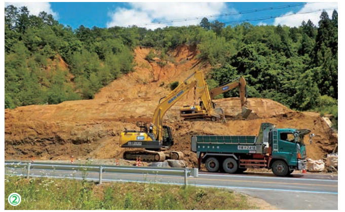
② 崩落してくる土砂を防ぐ擁壁を設置し、市道を守ります (令和元年12月完了予定)
