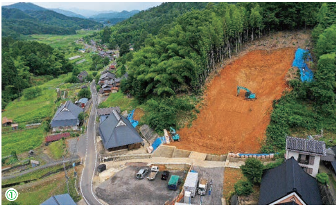
① 斜面の崩落を防ぐためコンクリートの枠に補強材を挿入する工事を行います (令和3年3月完了予定)
