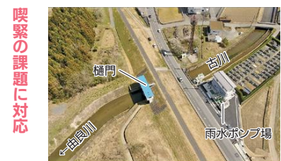
近年、大型の台風や集中豪雨が頻発し、樋門を閉める頻度が高まっています
