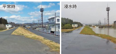
平成29年10月の台風21号による内水氾濫の様子
