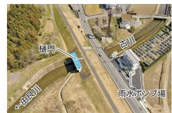
近年、大型の台風や集中豪雨が頻発し、樋門を閉める頻度が高まっています
