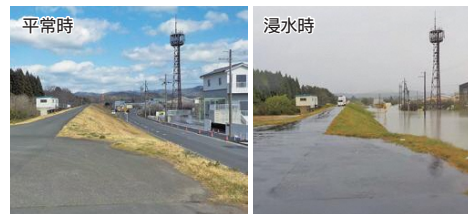
平成29年10月の台風21号による内水氾濫の様子
