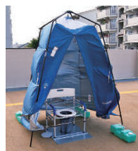
▲同センター前のマンホールには、簡易トイレを設置できます
