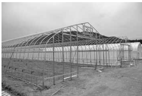
建築中のビニールハウス。生産基盤を整え、さらなるステップアップを狙います
