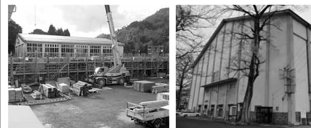
施設一体型の一貫校の整備を進める東綾小学校・東綾中学校 武道館との統合・再整備の計画が進む市民センター
