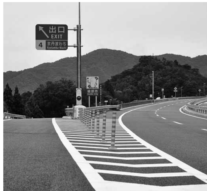
▲京都縦貫自動車道は昨年7月18日に全線開通。ヒトやモノの流れが変わりつつある
