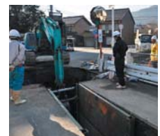
公共下水道工事
