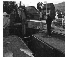
公共下水道工事
