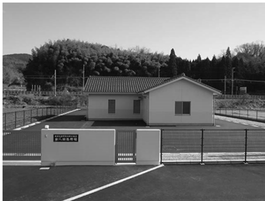
農業集落排水処理場
